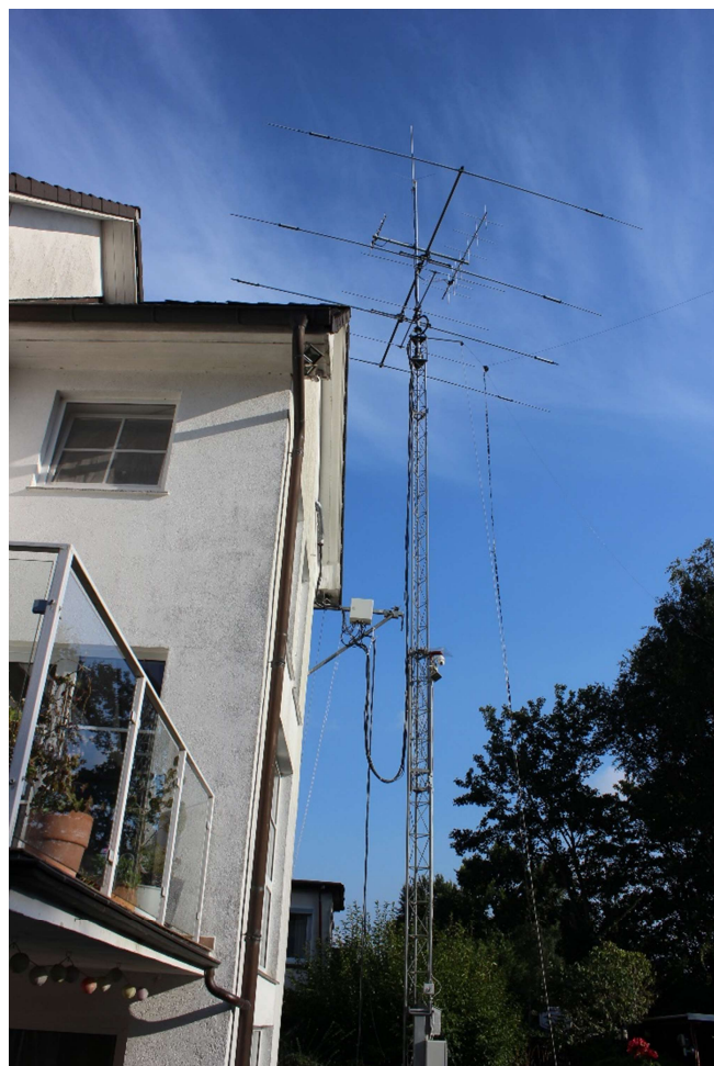
Und hier noch ein paar Eindrücke von der fertigen Antennenanlage...
