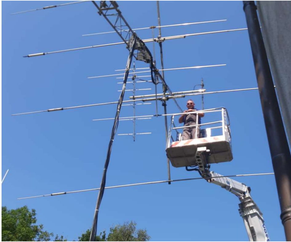
Das erste Aufrichten, noch mit der schwachen Winde und 4fach Seilzug. Langsam aber sicher...
