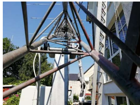
Das erste Aufrichten, noch mit der schwachen Winde und 4fach Seilzug. Langsam aber sicher...
