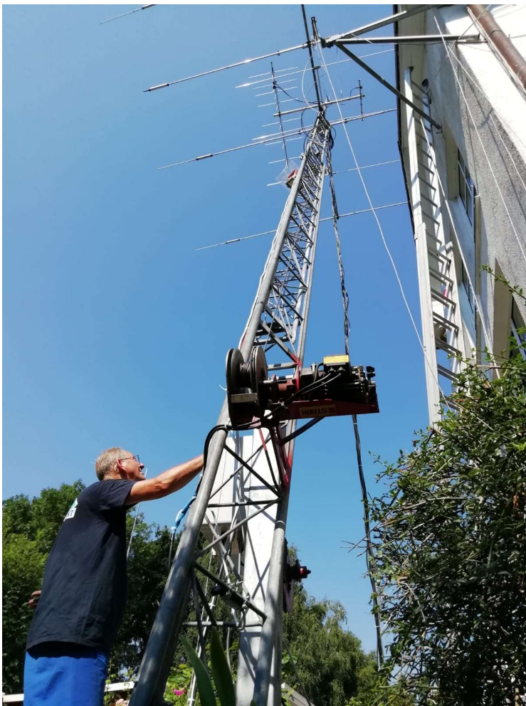
Aufgrund der Nähe zum Haus, ist hier leider nicht anders machbar, muss der Mast beim Kippen etwas ausgefahren bleiben. Sonst kollidiert der Beam mit dem Dach!
